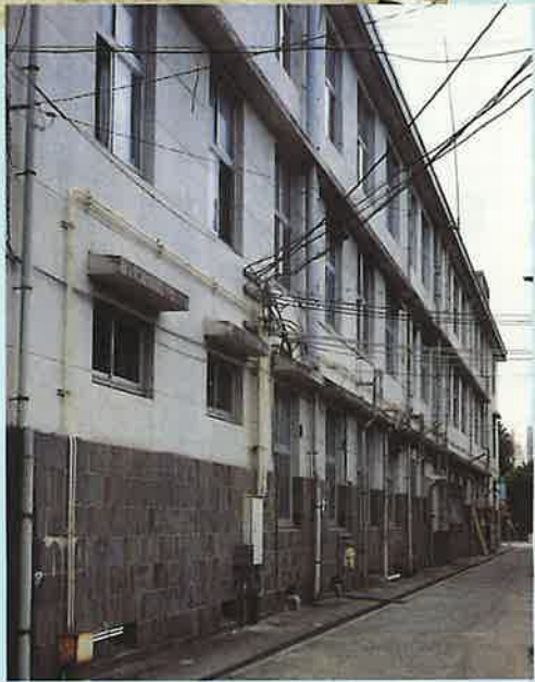
東棟(右奥がプール)
